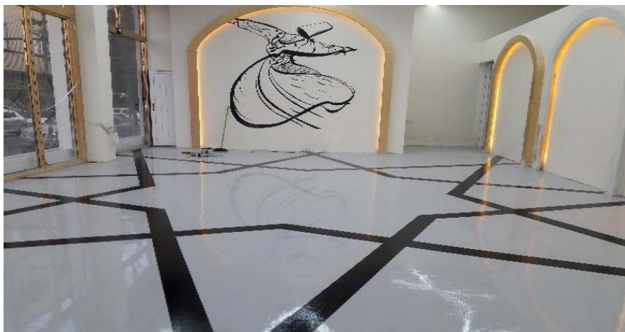
۱ پروژه کفپوش اپوکسی رستوران شهرک غرب
