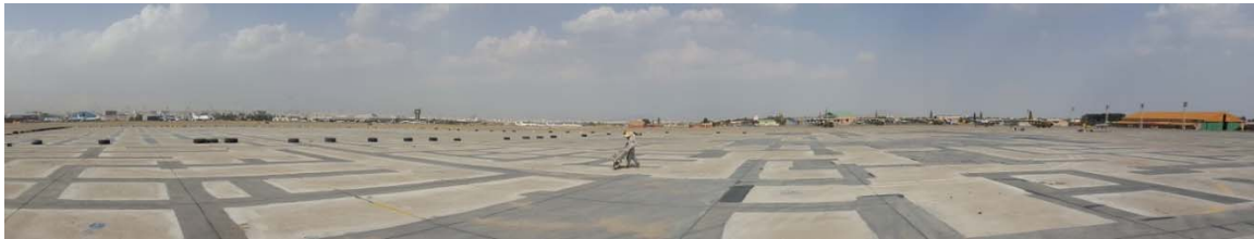
ترمیم کفسازی ایرون آشیانه ۷۰۷-۷۴۷ فرودگاه مهرآباد
