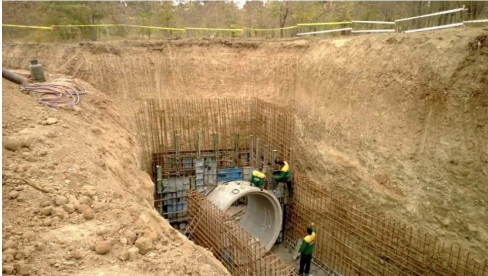
لوله گذاری کانال انتقال آب دریاچه چیتگر در پروژه تونل حکیم
