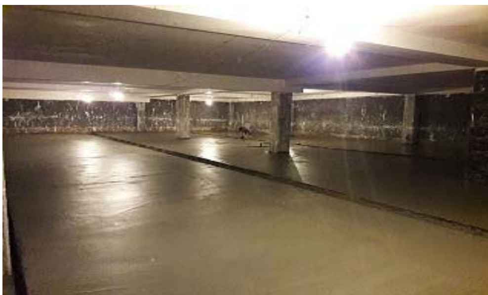
کف سازی پروژه ساختمان اداری تجاری آماتیس گرمدره
