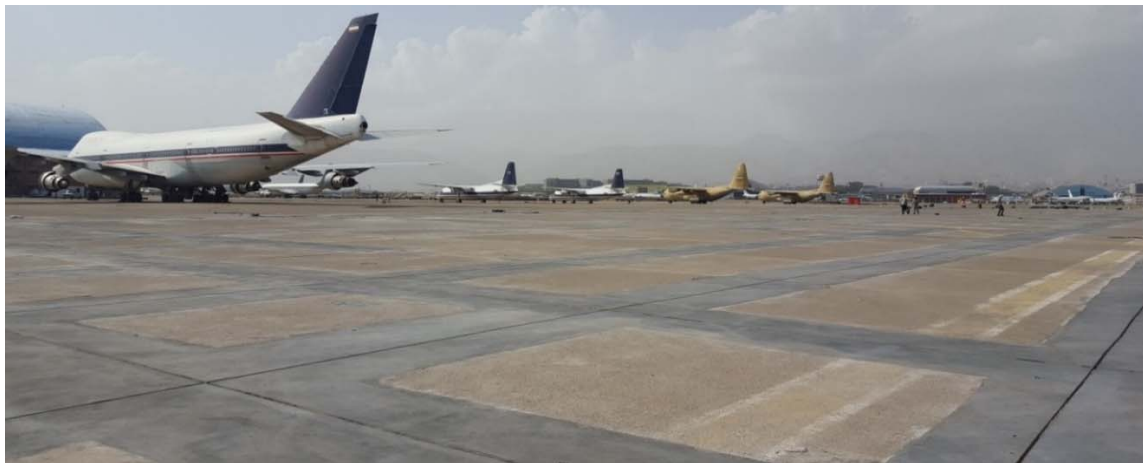
ترمیم کفسازی ایرون آشیانه ۷۰۷-۷۴۷ فرودگاه مهرآباد
