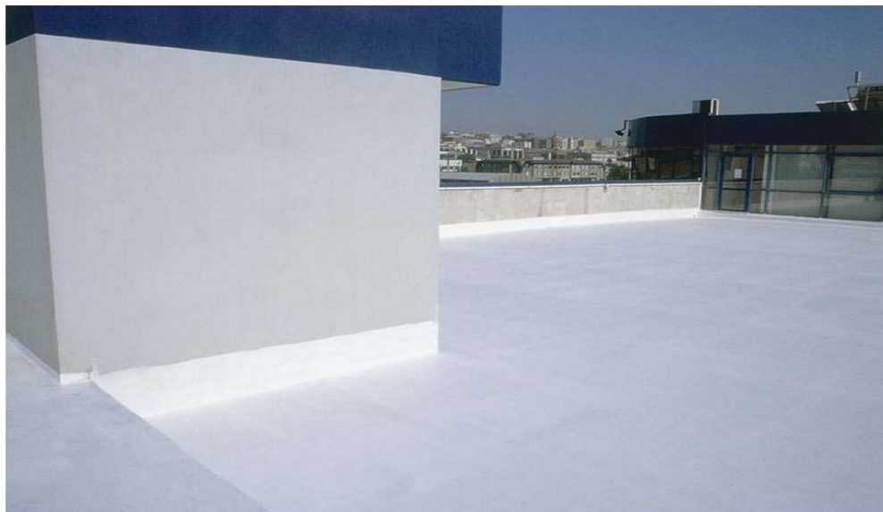
آببندی روف گاردن پروژه ساختمانی پاسداران
